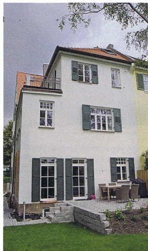
Neu saniertes Münchner Jugendstildoppelhaushälfte Architekten: Architekturbüro Wagner, Landshut
